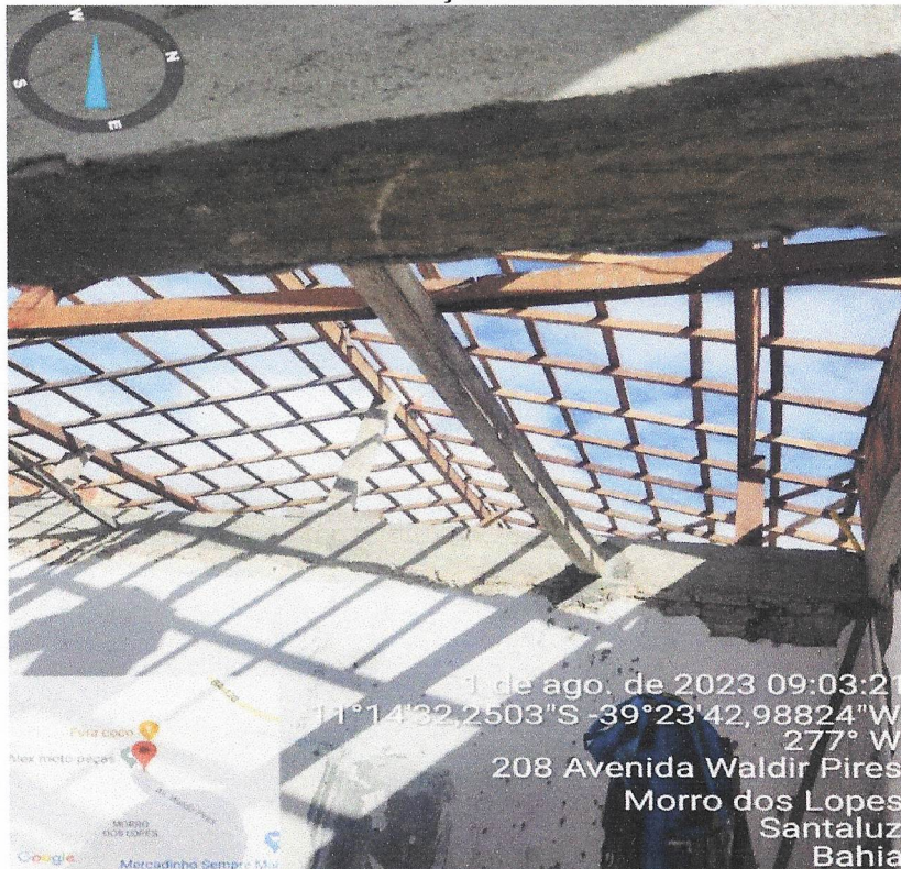
Foto 36- EXECUÇÃO DO TELHADO
