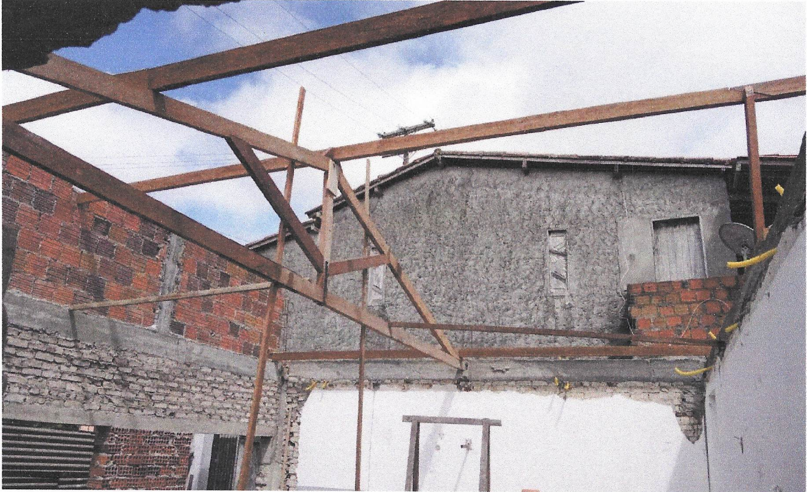
Foto 42- EXECUÇÃO DO TELHADO
