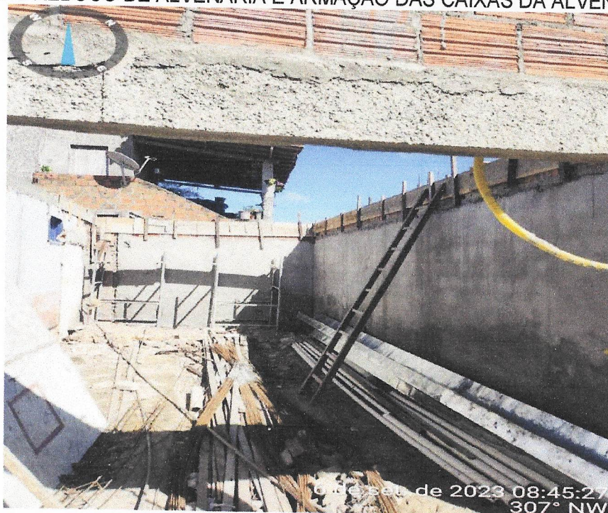
Foto 6: REBOCO DE ALVENARIA E ARMAÇÃO DAS CAIXAS DA ALVENARIA
