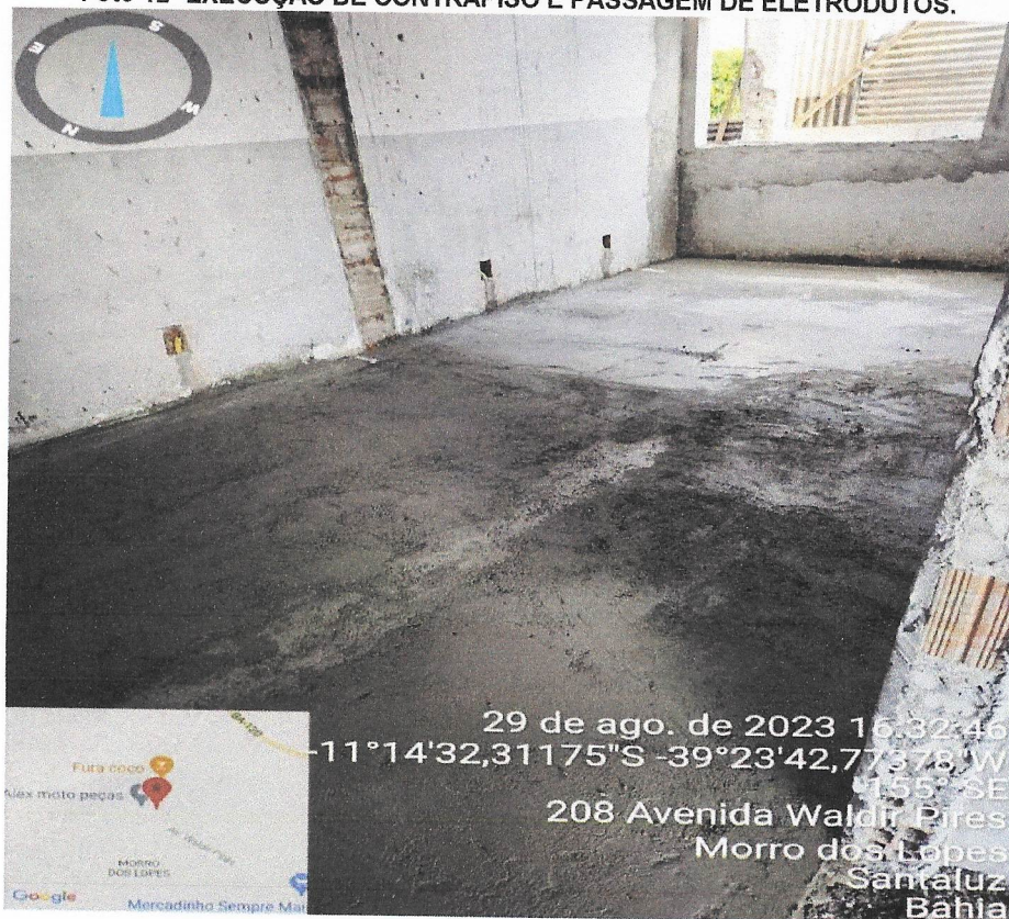
Foto 12- EXECUÇÃO DE CONTRAPISO E PASSAGEM DE ELETRODUTOS.
