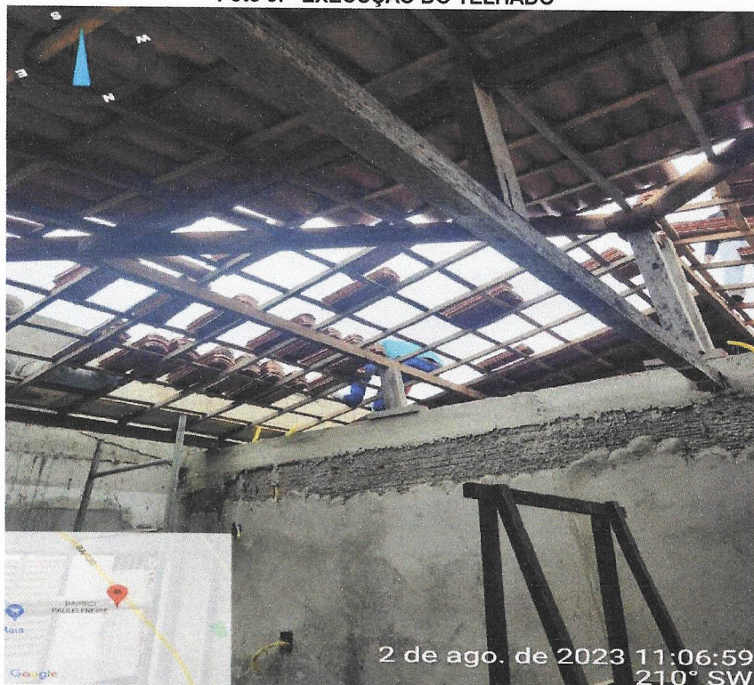
Foto 37- EXECUÇÃO DO TELHADO
