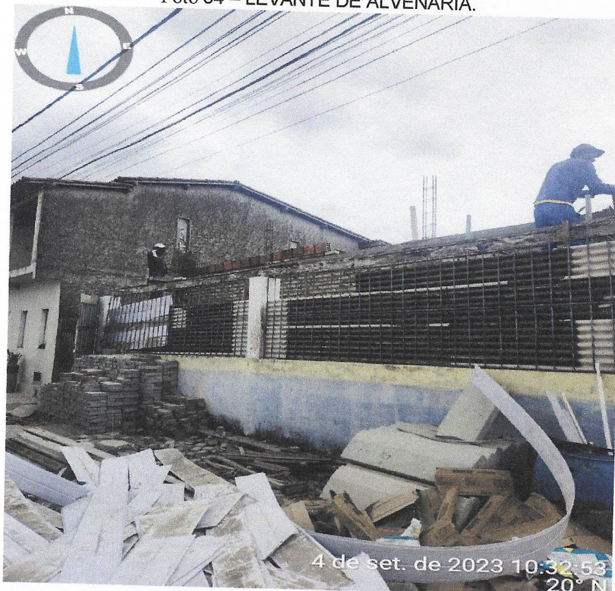
Foto 04 – LEVANTE DE ALVENARIA.
