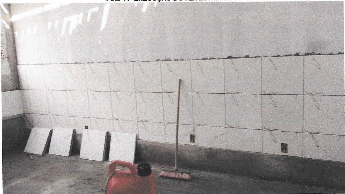
Foto 41- EXECUÇÃO DO REVESTIMENTO
