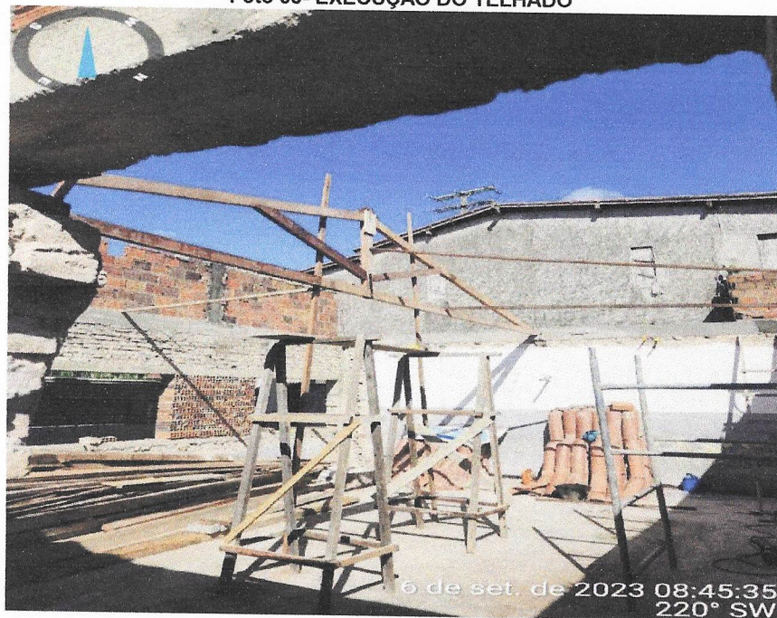
Foto 38- EXECUÇÃO DO TELHADO
