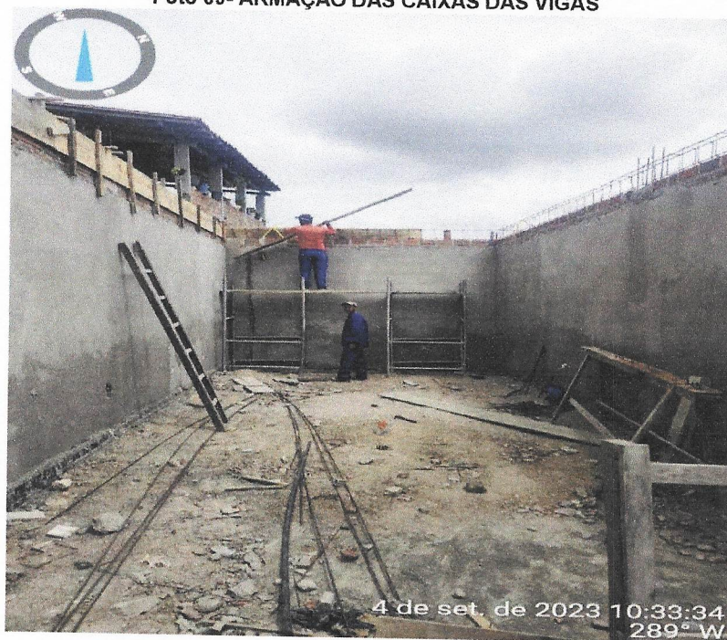
Foto 09- ARMAÇÃO DAS CAIXAS DAS VIGAS
