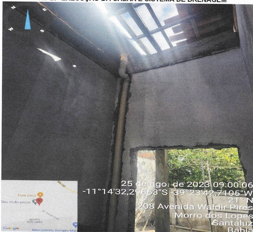
Foto 25- EXECUÇÃO DA CALHA E SISTEMA DE DRENAGEM
