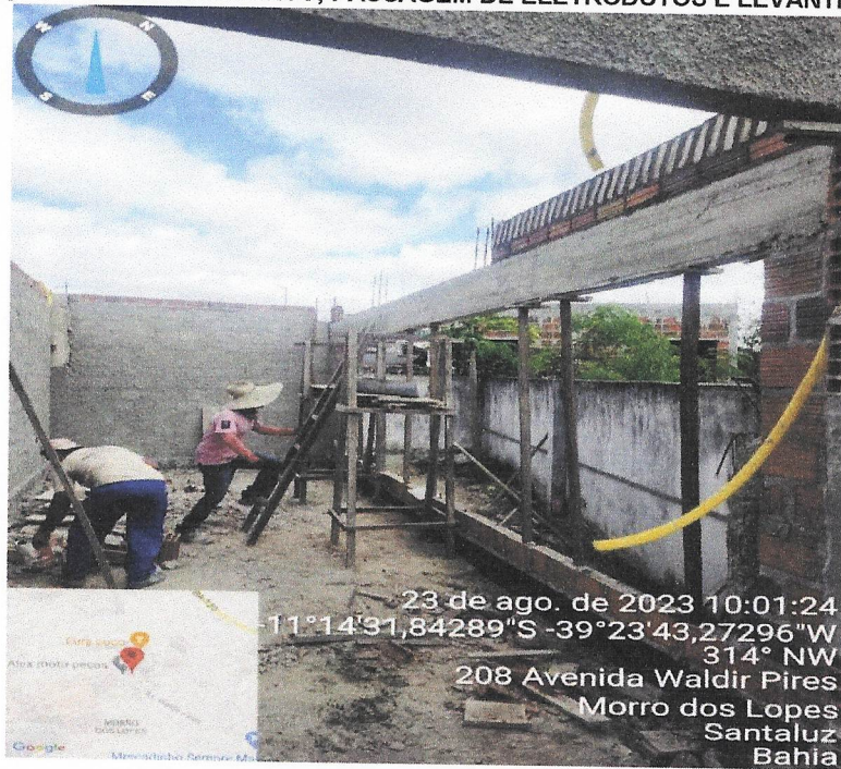
Foto 14- EXECUÇÃO DE REBOCO E PASSAGEM DE ELETRODUTO.
