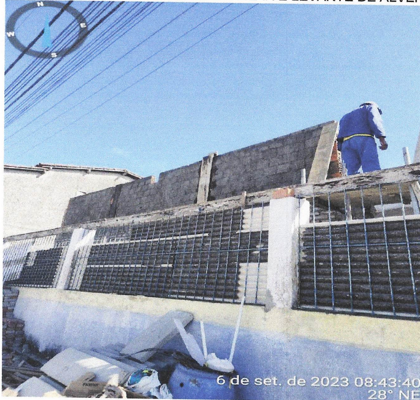
Foto 5: CHAPISCO, CONCRETAGEM DE PILAR E LEVANTE DE ALVENARIA
