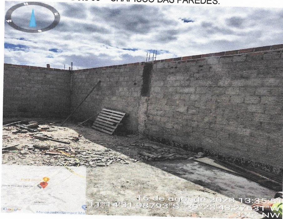
Foto 04 – LEVANTE DE ALVENARIA.
