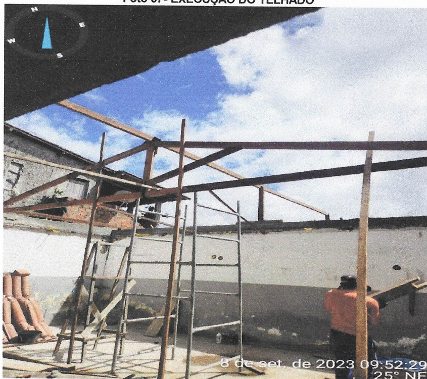
Foto 37- EXECUÇÃO DO TELHADO
